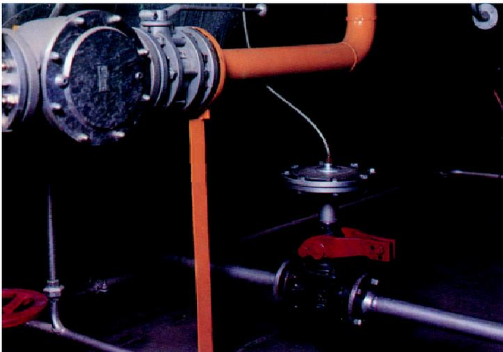
La combinación de la Válvula de purga continua de sales\* y la Válvula de cierre rápido para la purga de fangos y lodos\*, es indispensable para optimizar el rendimiento de la caldera, con la máxima seguridad y disponibilidad de la misma.
